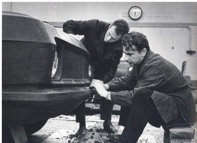
На снимке: Л.И.Циколенко (справа) изготавливает из пластилина новую модель Волги ГАЗ-3102 для показа внешнего вида машины в натуральную величину государственной приемной комиссии на Горьковском автозаводе
